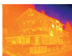
Imagem térmica sem ScaleAssist
